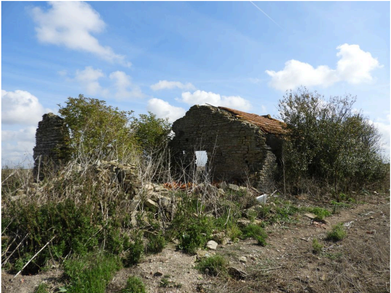
Les ruines du logis vues depuis l'ouest.
