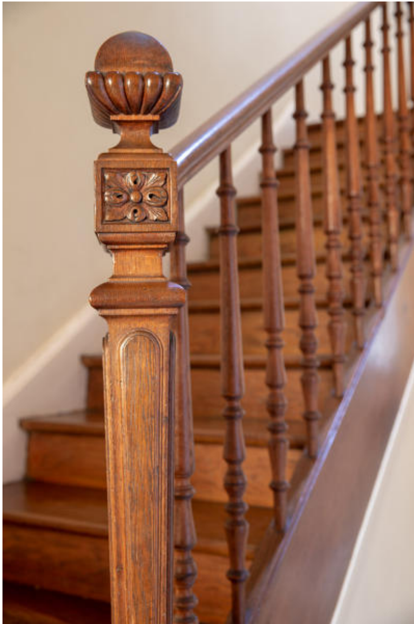
Vue du poteau de départ de l'escalier.
