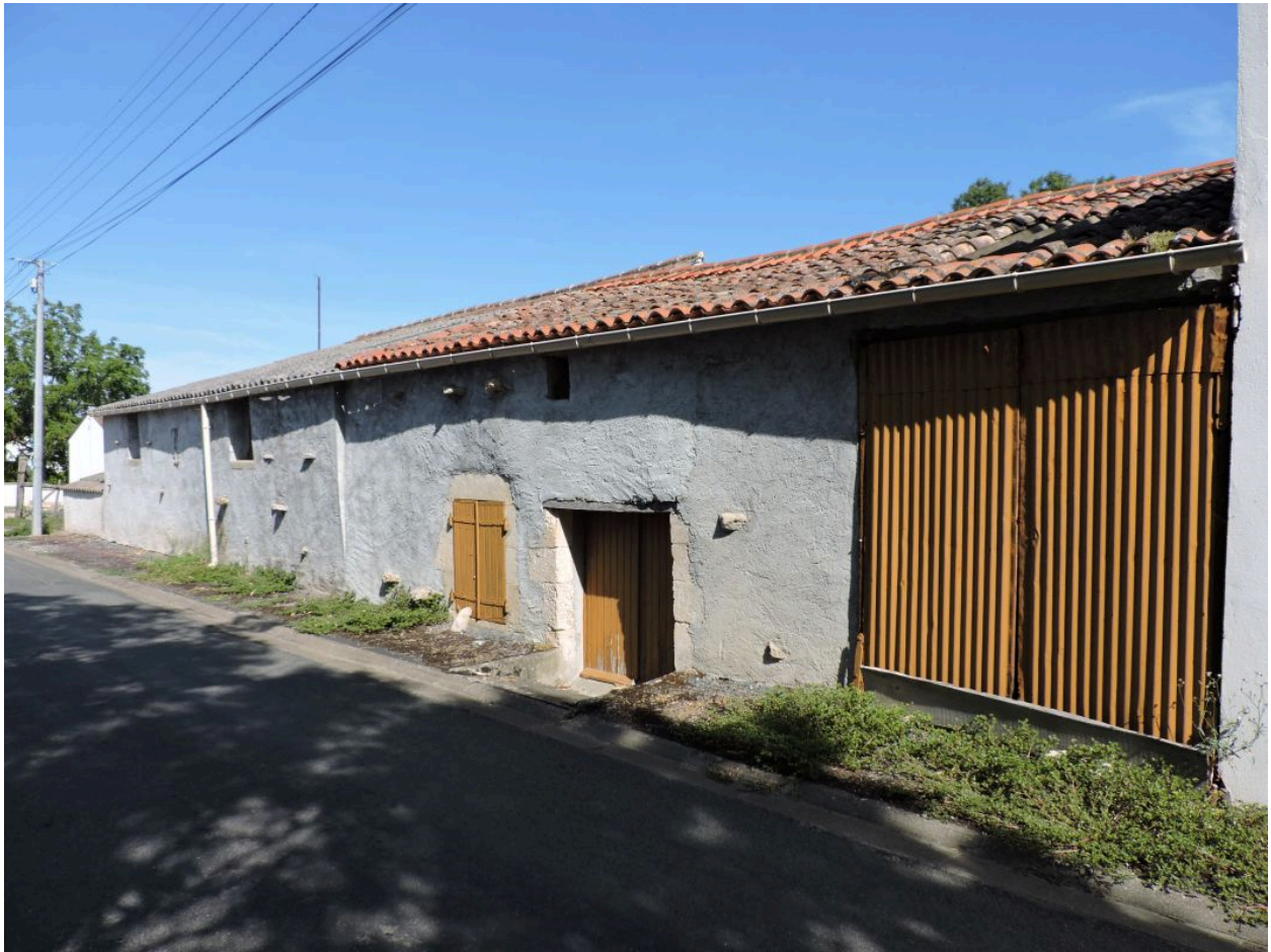
L'ancien logement (début du 19e siècle ?) le long de la rue, vu depuis le sud-est.
