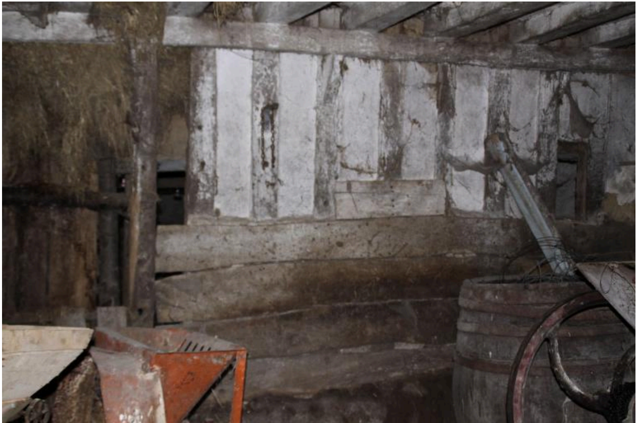
Etable 2 : détail de la cloison à pan de bois.
