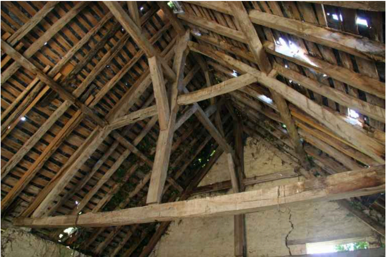
La grange : charpente.
