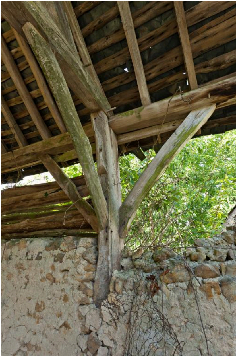
Hangar, détail : poteau de bois noyé dans la maçonnerie.
