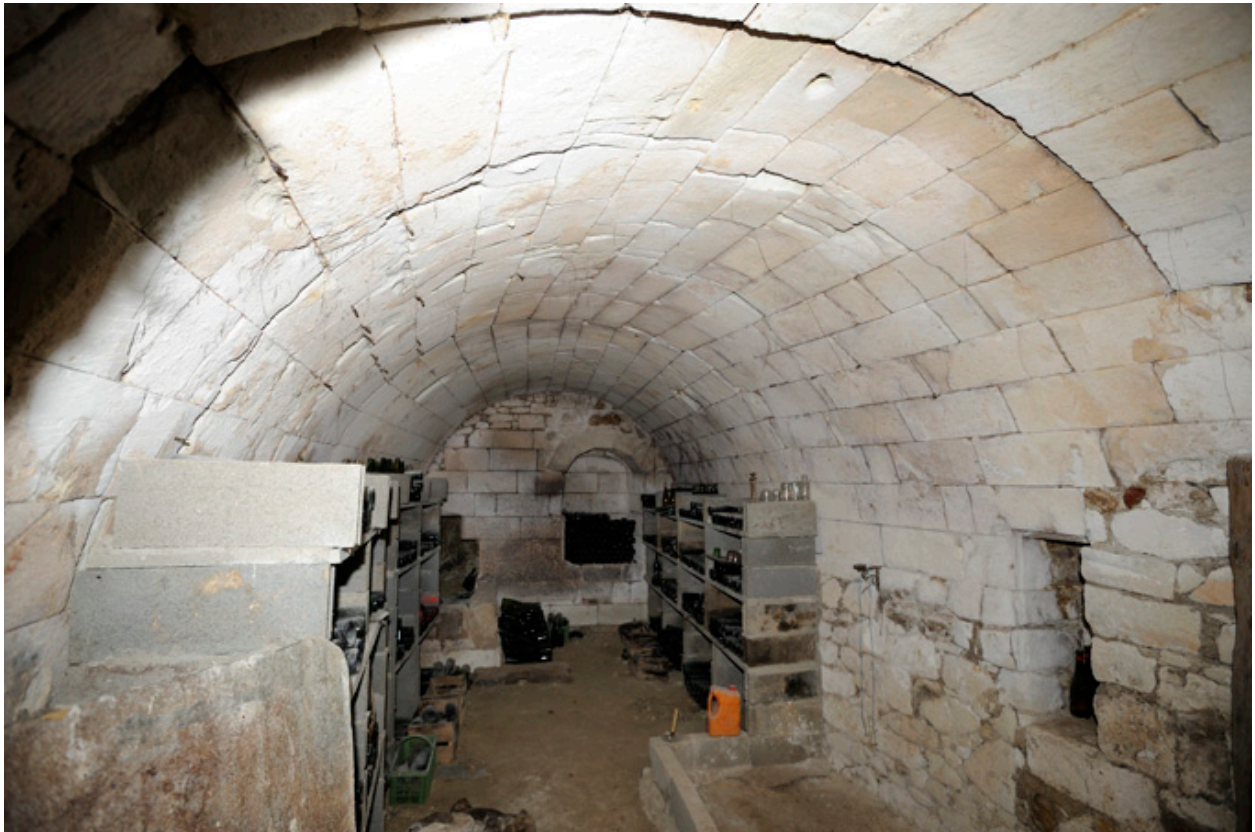
Cave sud-est (XIXe siècle) : intérieur, voûte.
