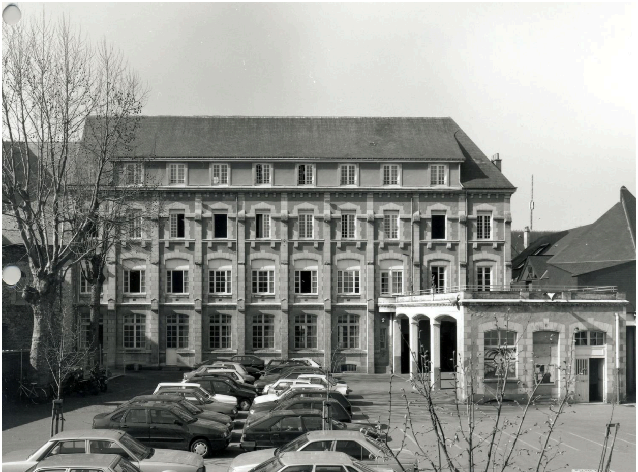
Externat Saint-Maurille, bâtiment de classes de 1924 construit au nord de la collégiale Saint-Martin : élévation sur la cour et préau adjacent.
