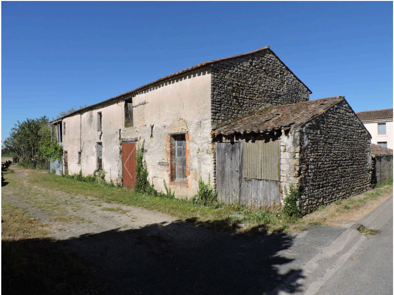
L'ancienne ferme, perpendiculaire à la voie, vue depuis le nord-est.
