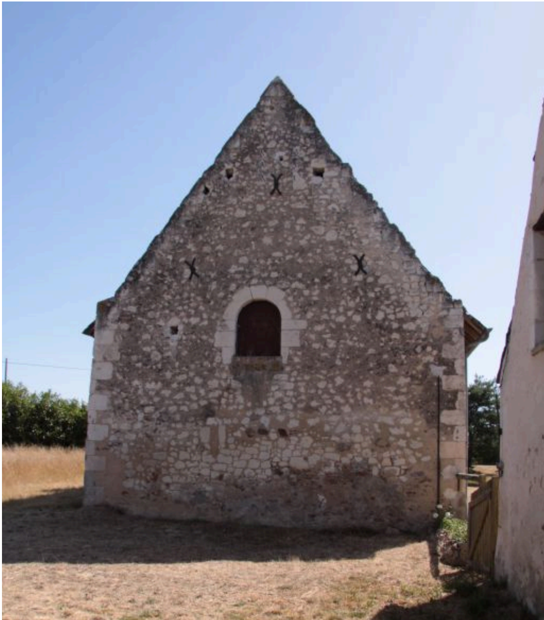
La grange, pignon nord.
