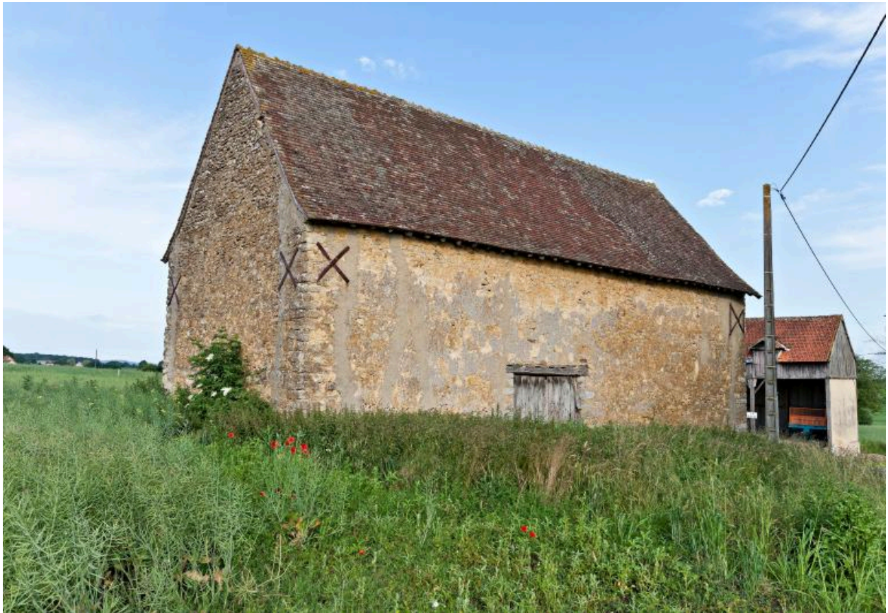
La Borde. Elévation postérieure de la grange, vue depuis le chemin.
