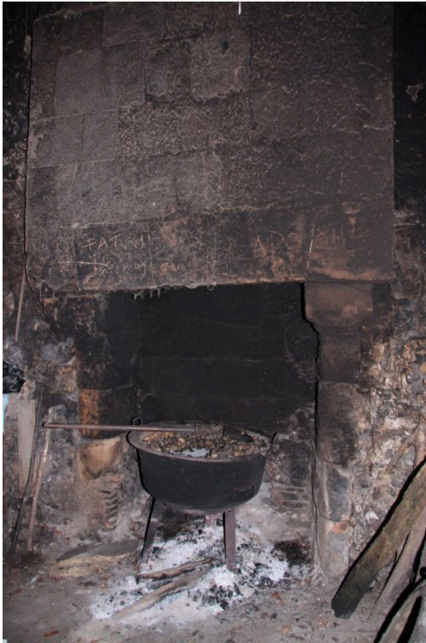
Grosse tour S-0, rez-de-chaussée : cheminée (1606).
