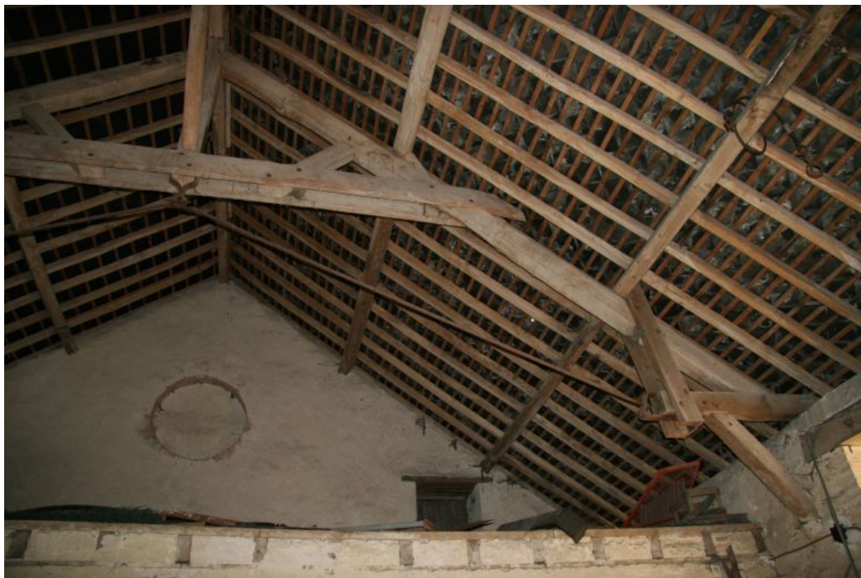
La grange avec la charpente boulonnée.
