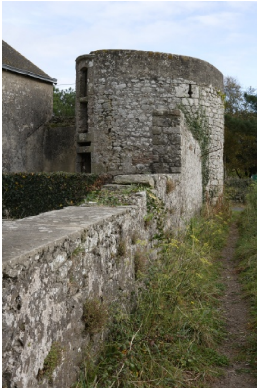
Mur de clôture. Tour d'angle sud-est.
