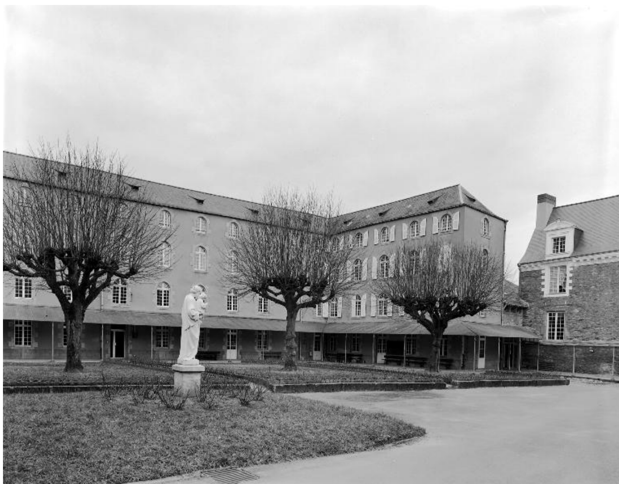
Cour postérieure, bâtiment sud : corps principal et aile ouest en retour d'équerre.
