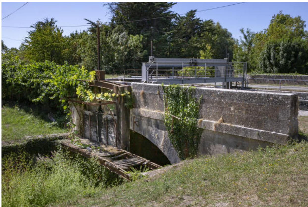
L'aqueduc vu côté amont, depuis le nord-est.
