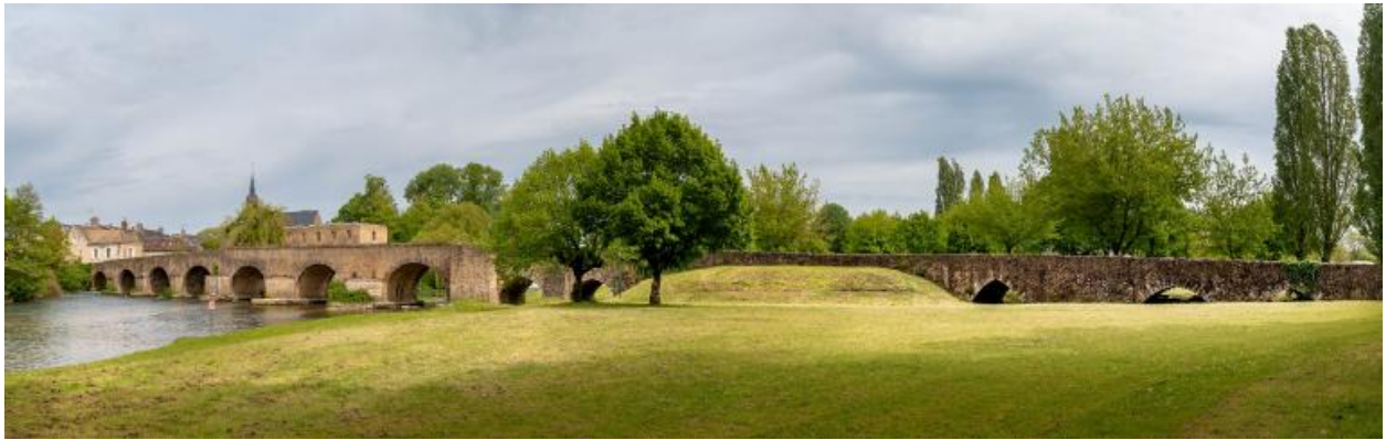
Le pont, face sud.
