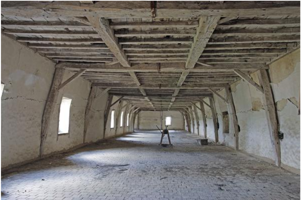
Le corps de commons dit "grange d'abondance", premier niveau de comble.
