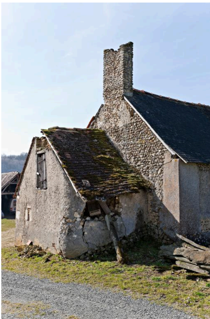
Maison 1, pignon est : bâtiment du four à pain.
