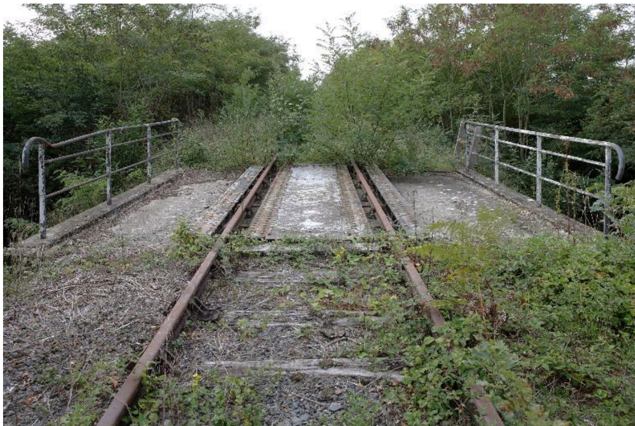
Vue du dessus d'un pont-rail à poutres jumelles.
