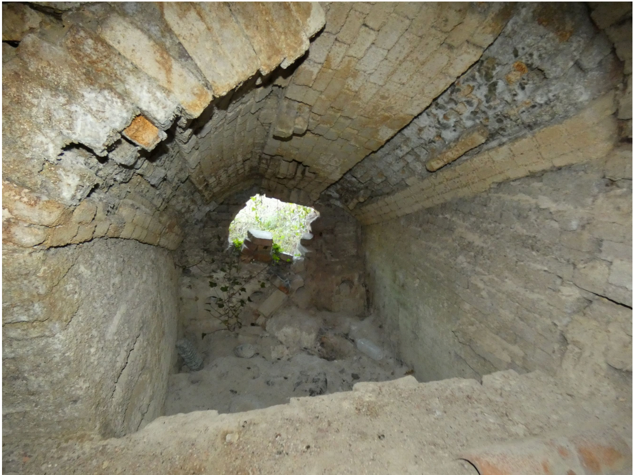
Un des deux foyers du second four, vu depuis le sud.
