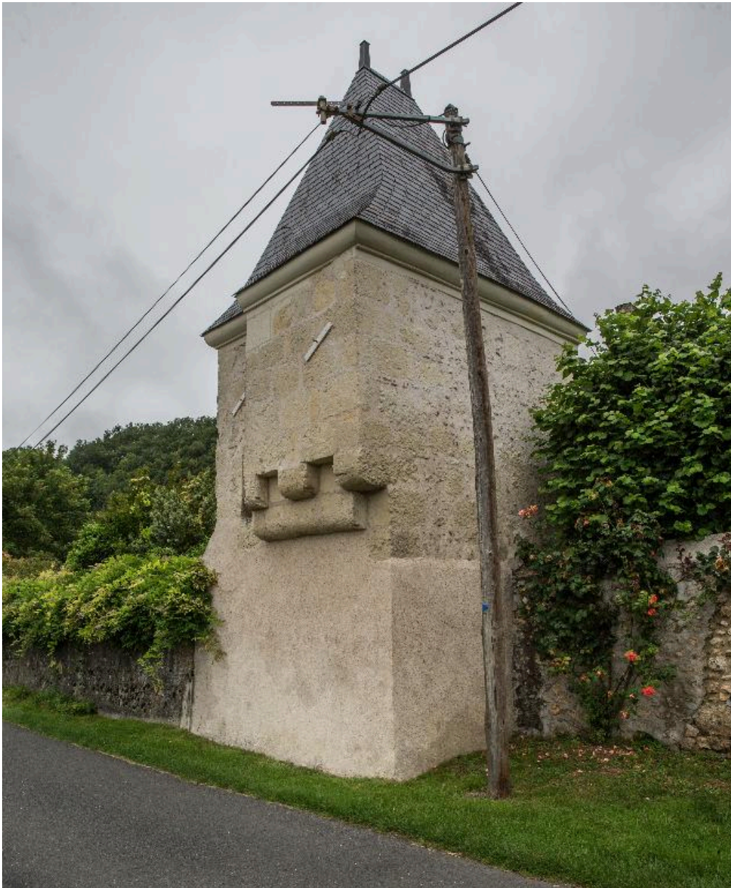
Pavillon sud-est, côté route.
