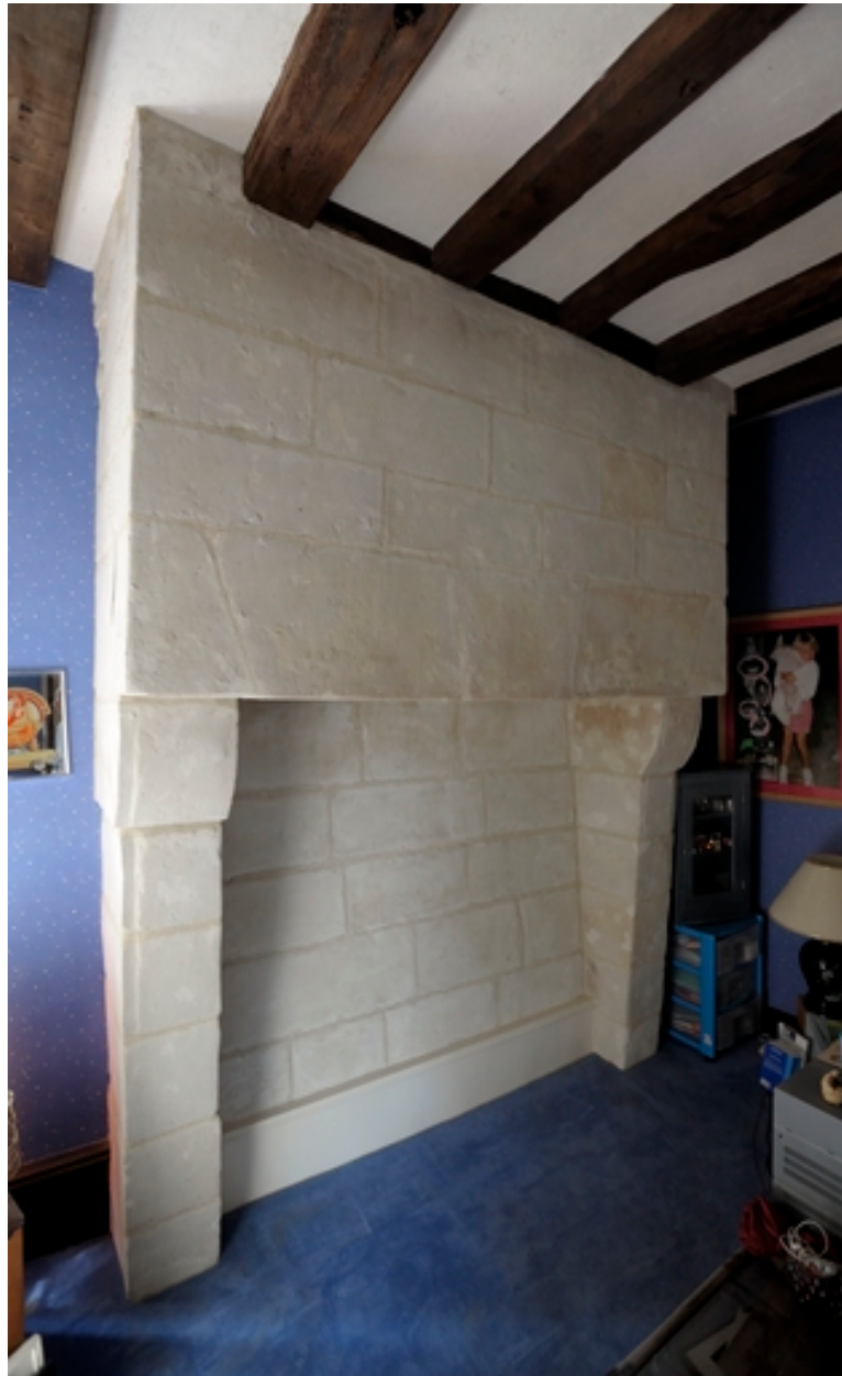
Etage, salle sud. Cheminée du XVIIe siècle.
