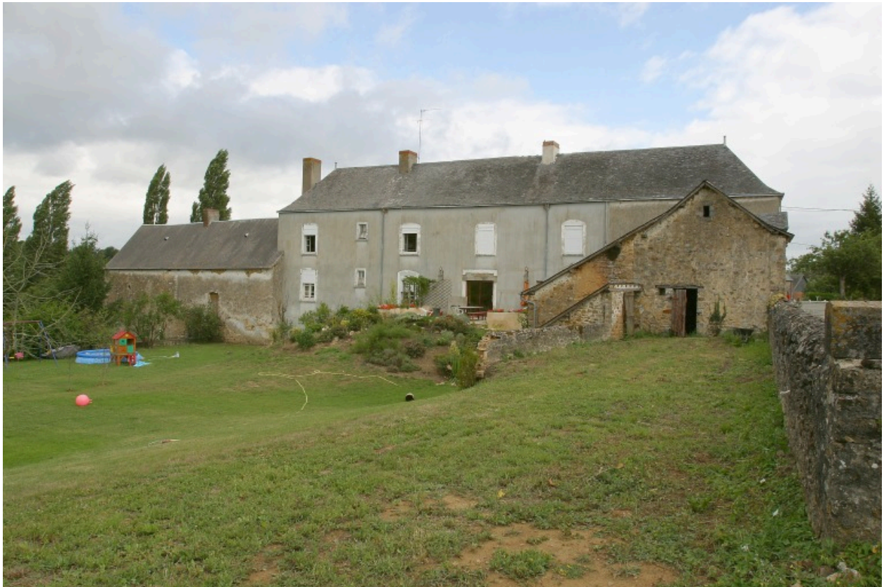
Façade postérieure vue depuis la route de Thorigné.
