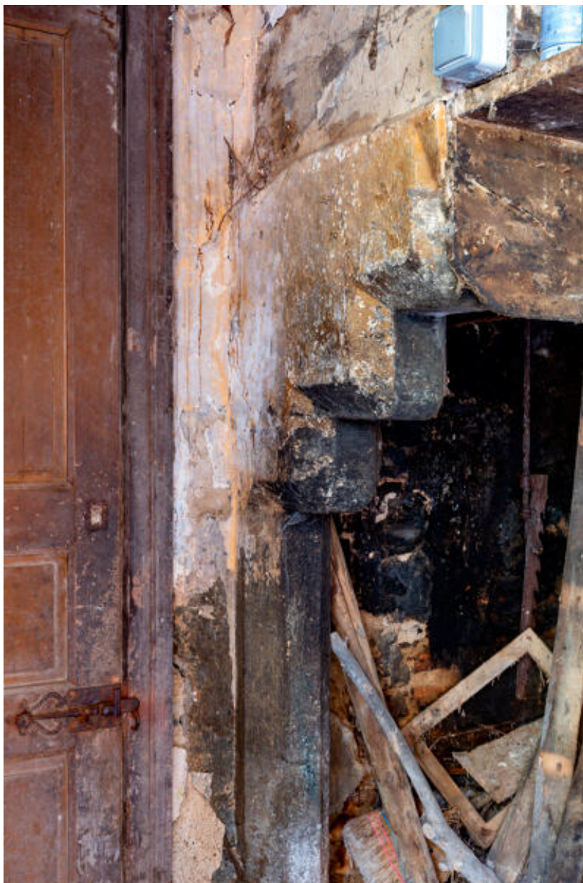
La cheminée de l'ancienne cuisine, détail.
