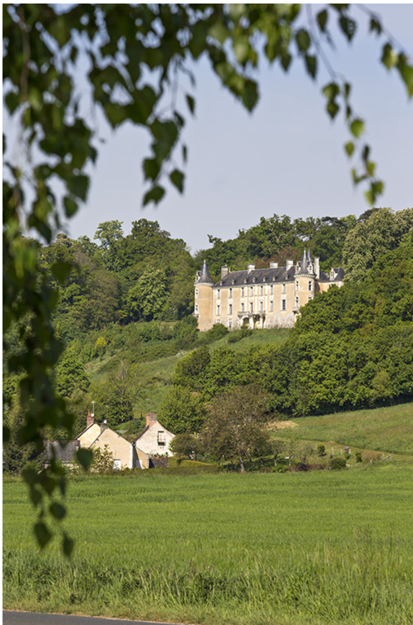
Vue d'ensemble depuis la RD 305 : le château surplombe l'écart de la Tête Noire.
