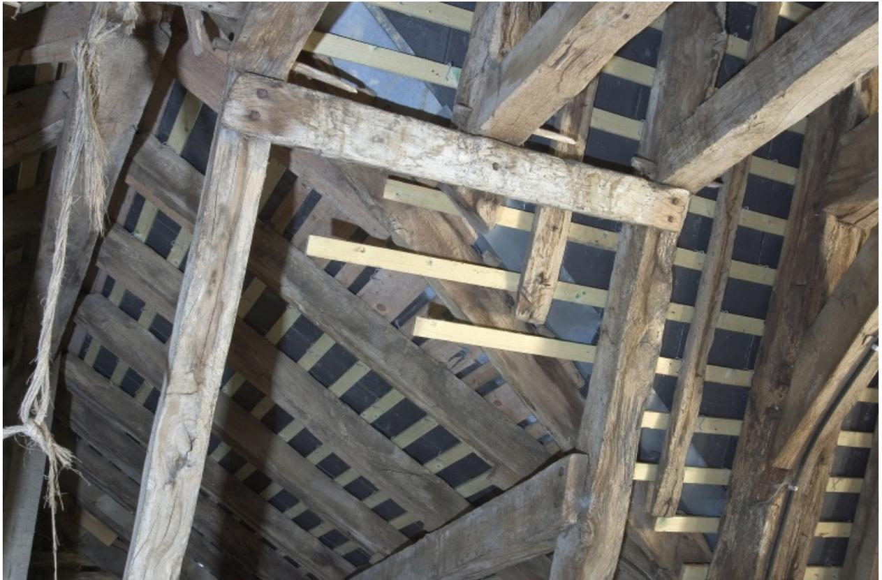
Intérieur du logis, comble : détail de la partie de la charpente située à la jonction entre les deux corps.
