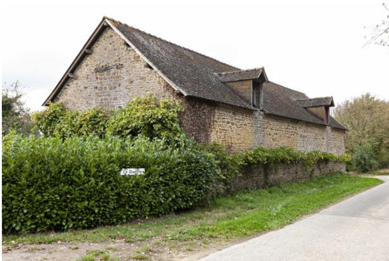
Grange et étable, nord-est, vue depuis l'est.
