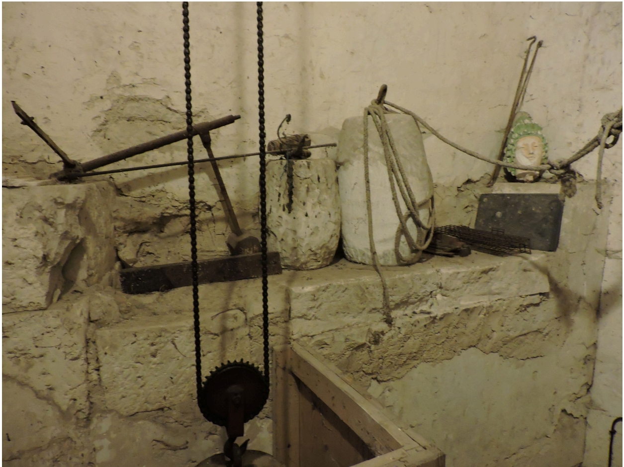
Appui d'une ancienne baie arasée sur la façade occidentale, vue depuis l'intérieur, sous le clocher.
