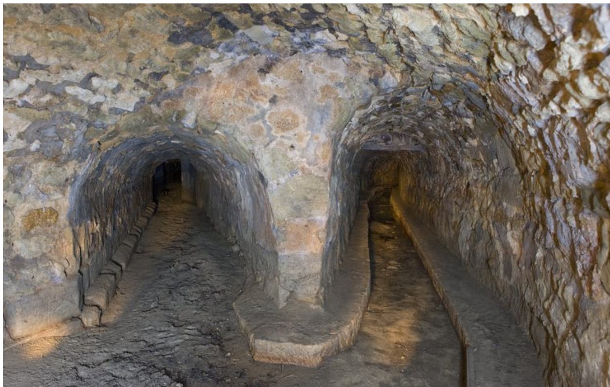
Sous-sols, confluence de canalisations du système hydraulique.
