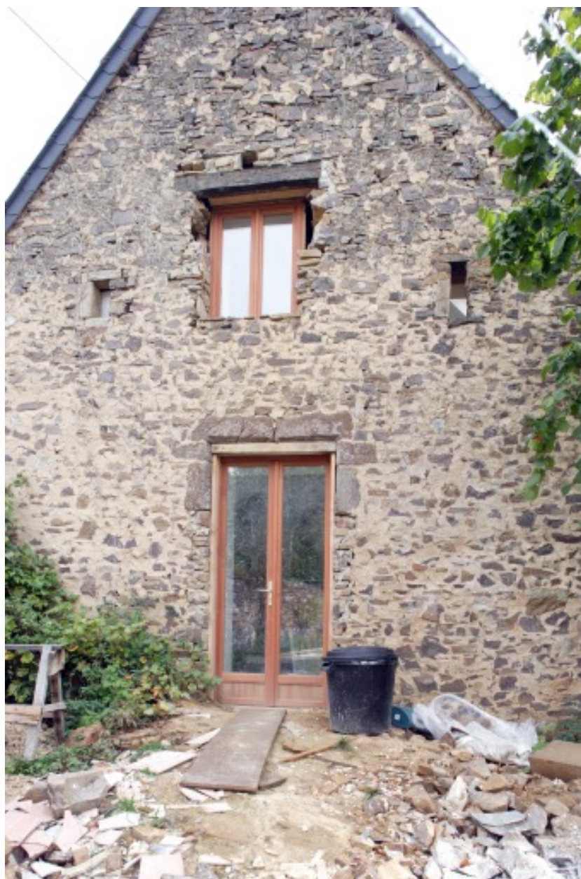
Vue partielle du mur-pignon ouest.
