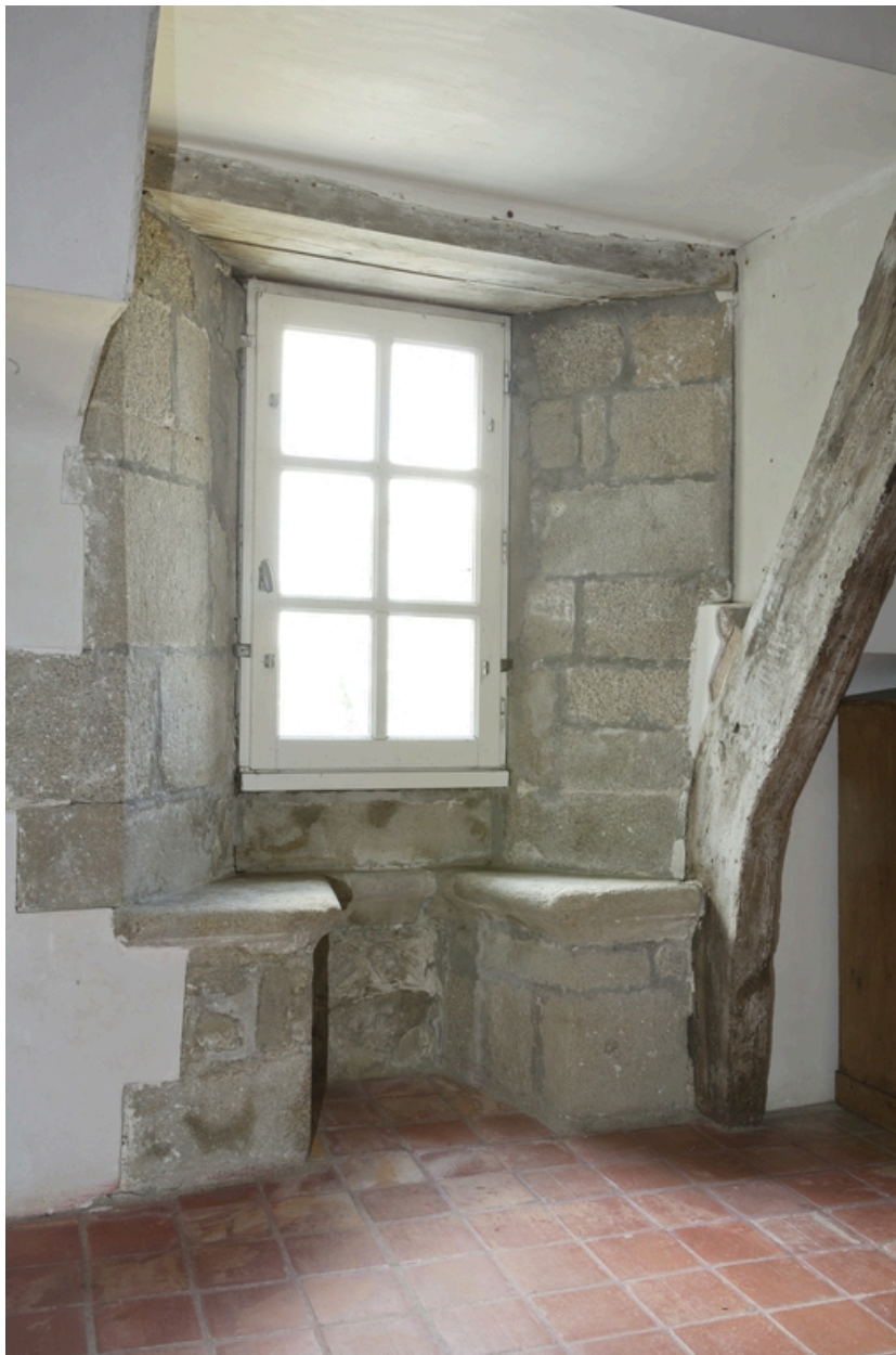
Logis. Aile nord. 1er étage. Détail de la fenêtre à coussièges.
