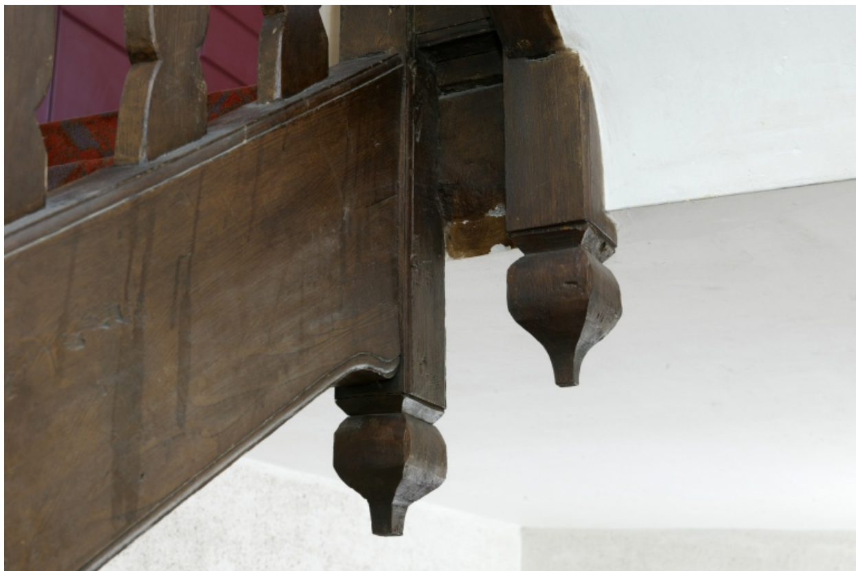
Détail des poinçons de l'escalier.
