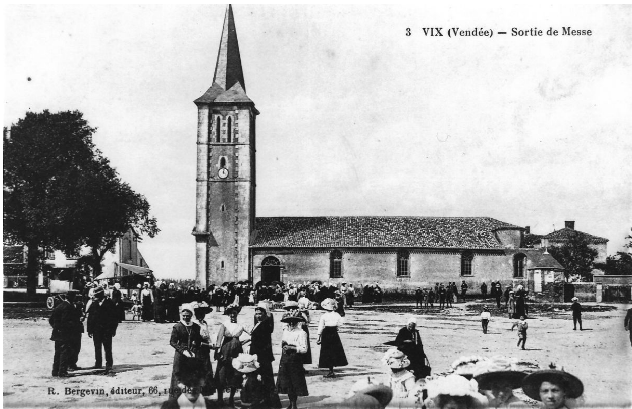
L'église vue depuis le sud vers 1910.
