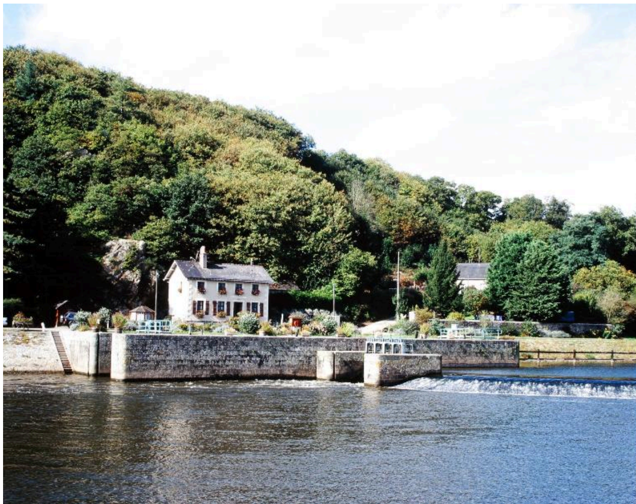
La maison éclusière, l'écluse et le pertuis vus depuis la rive gauche.
