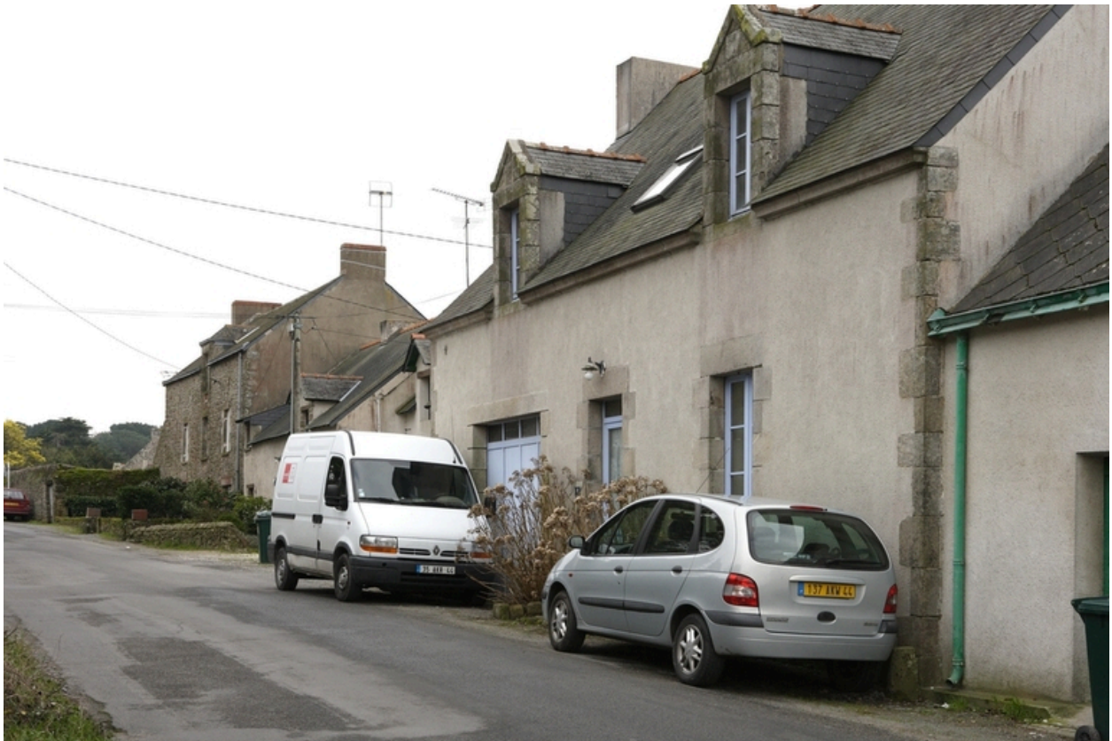
Vue d'ensemble de la rangée depuis le nord-ouest.
