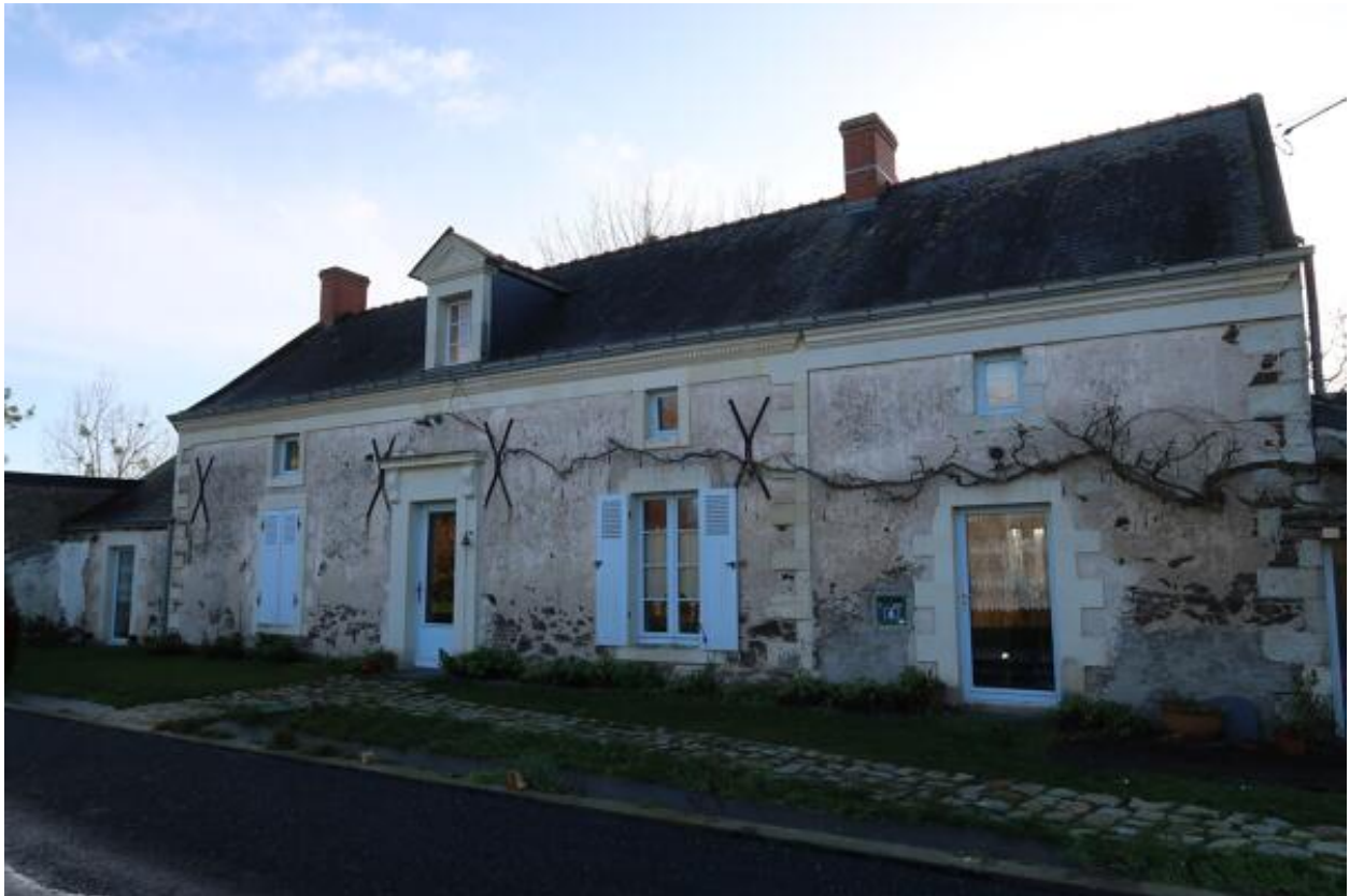
Le Ray-Granneau, 6 (3e quart 19e siècle, 1861). Vue de la ferme.
