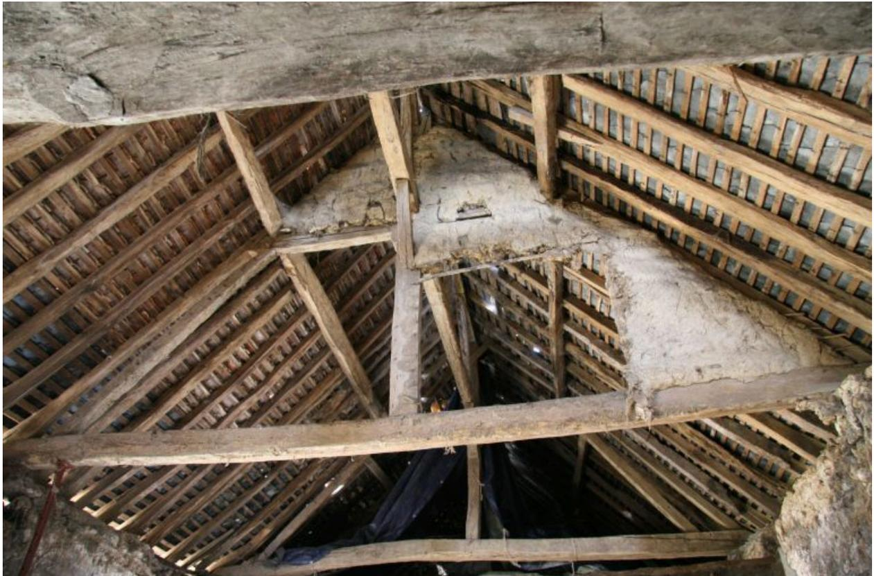
Cloison de séparation des combles à la hauteur du poteau dans le mur : vestiges d'un bâtiment en pan-de-bois ?
