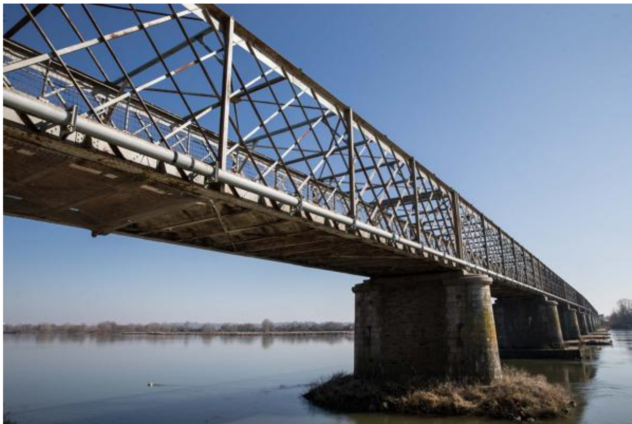
Piles et cage depuis la rive nord.
