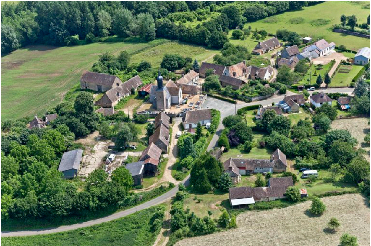
Vue aérienne depuis l'ouest.
