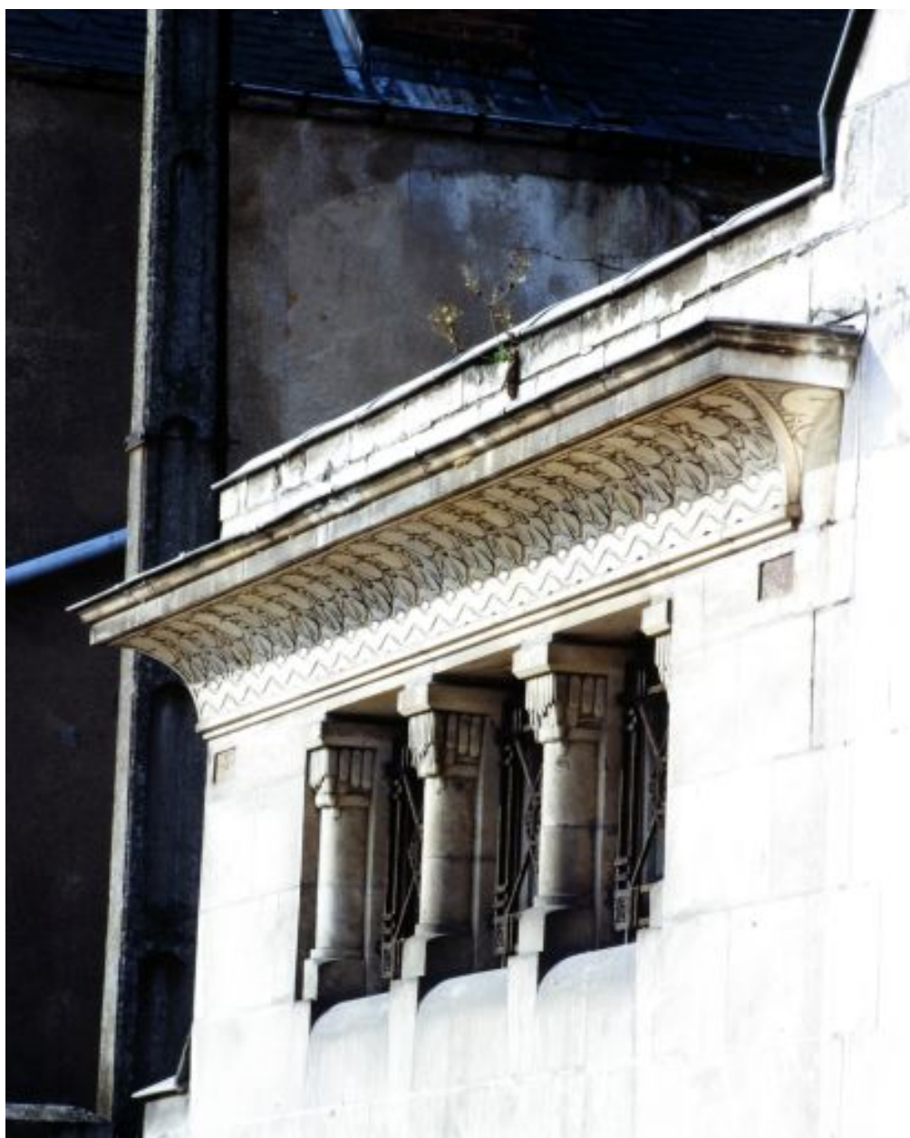
Elévation antérieure, extrémité sud, vue de détail : baies et corniche.
