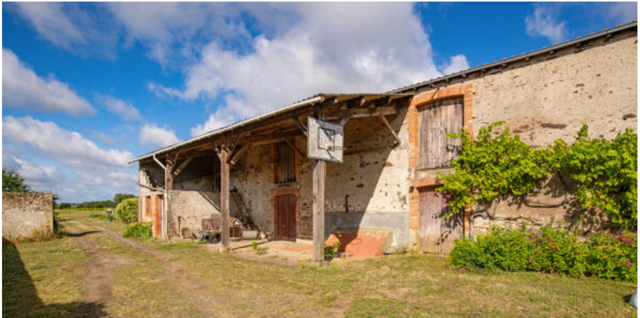
Vue générale des communs, depuis le nord.
