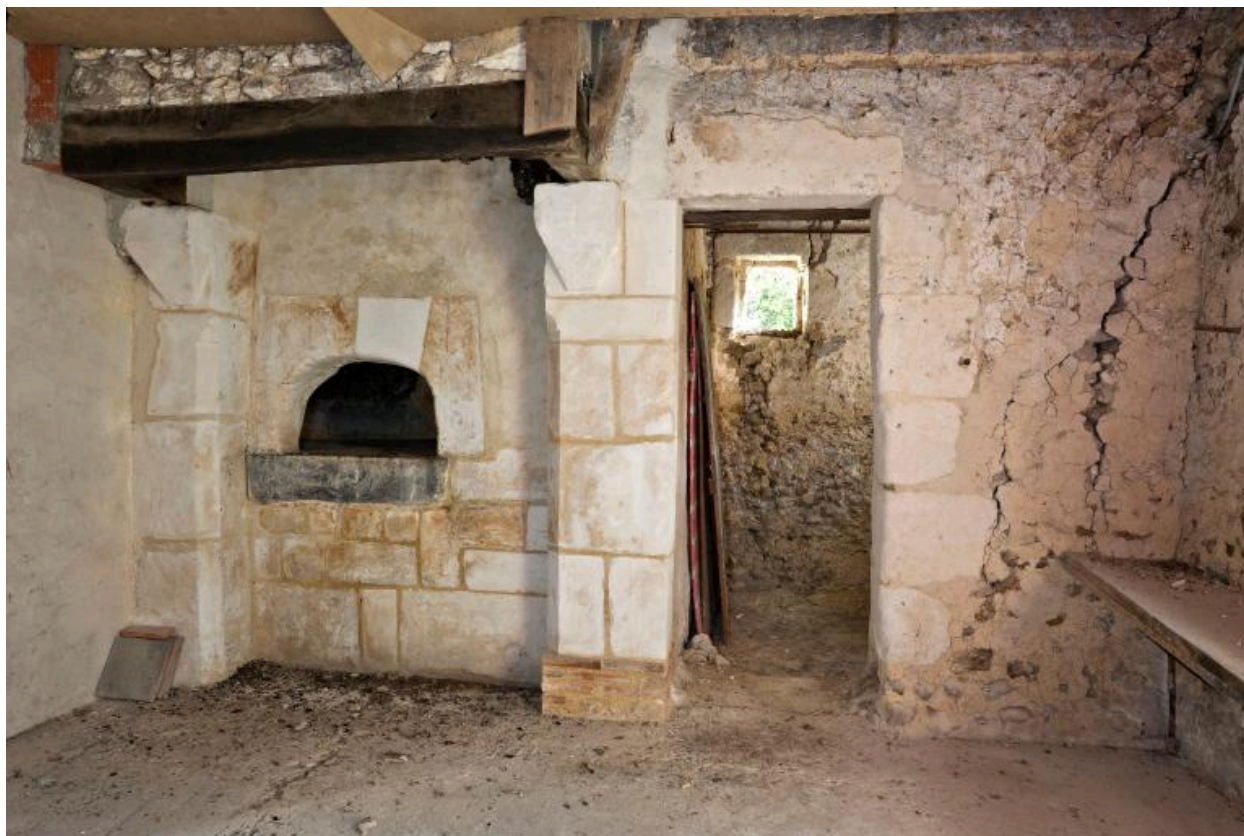
Maison 2 : pièce à feu et cheminée actuelle.
