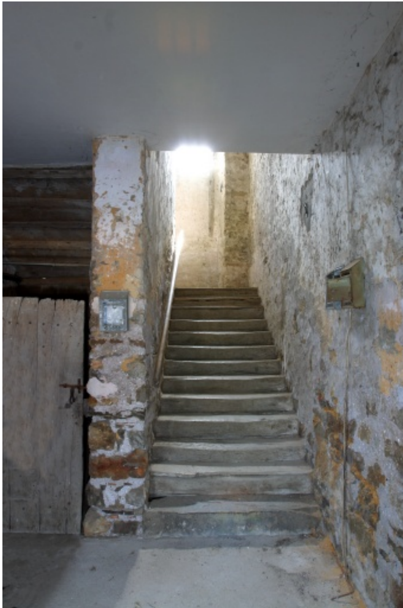
L'escalier vu depuis l'ouest.
