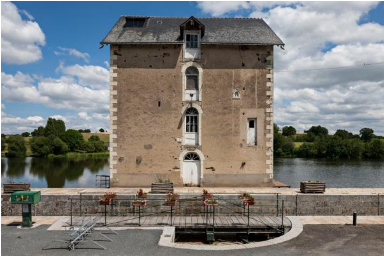
La façade ouest du moulin.
