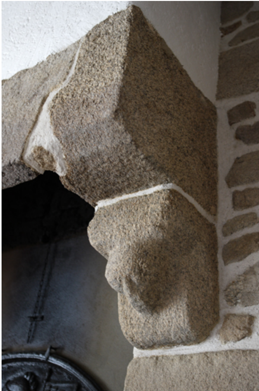
Logis. Aile nord-ouest. Détail du corbeau de droite de la cheminée.
