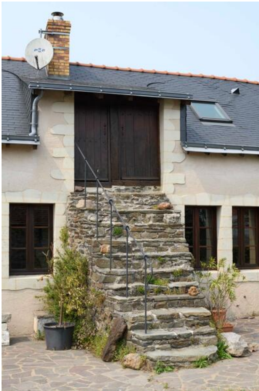
Escalier d'accès au comble.
