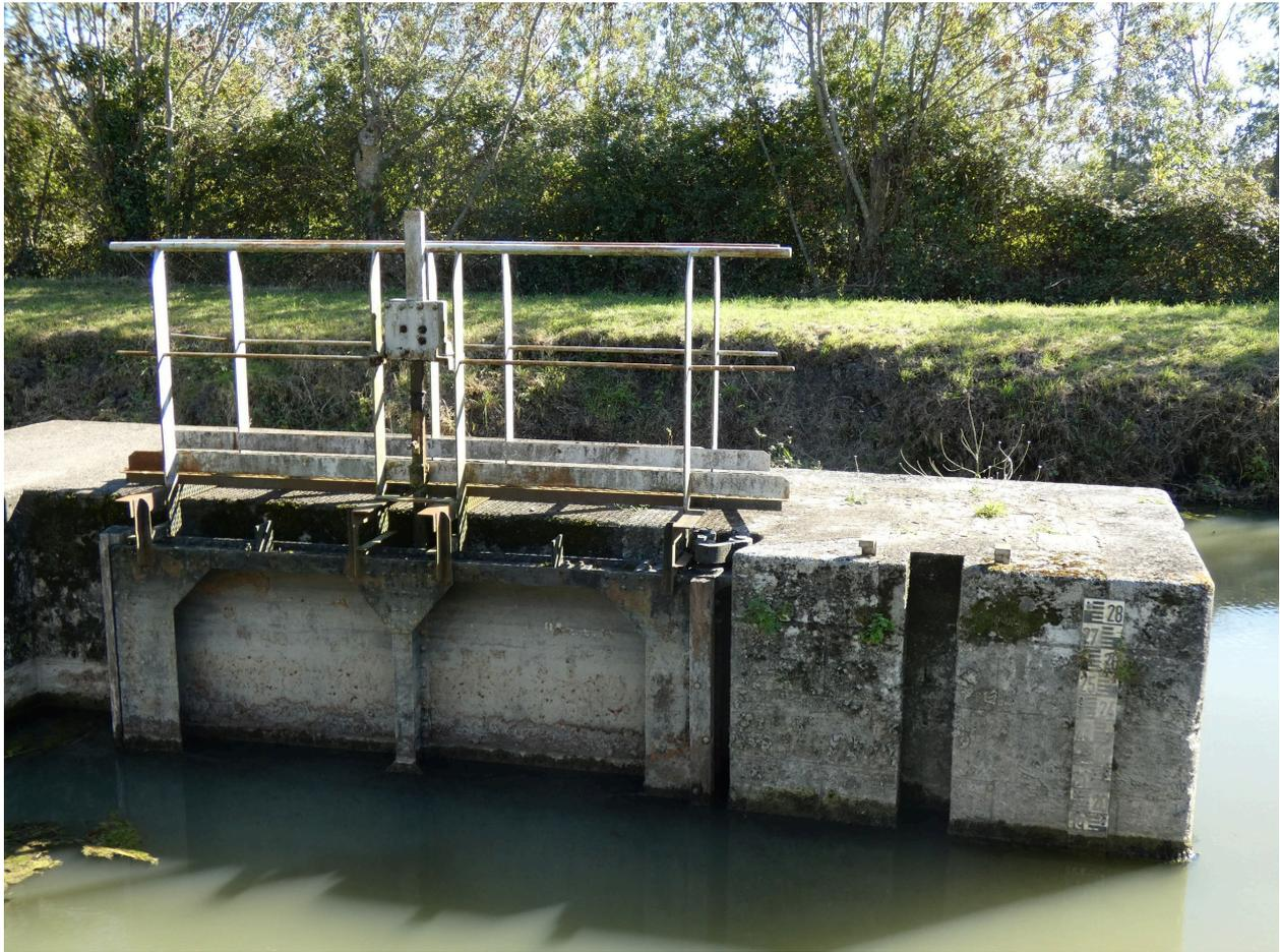
Détail de l'écluse : mur central, porte aval et échelle de mesure.
