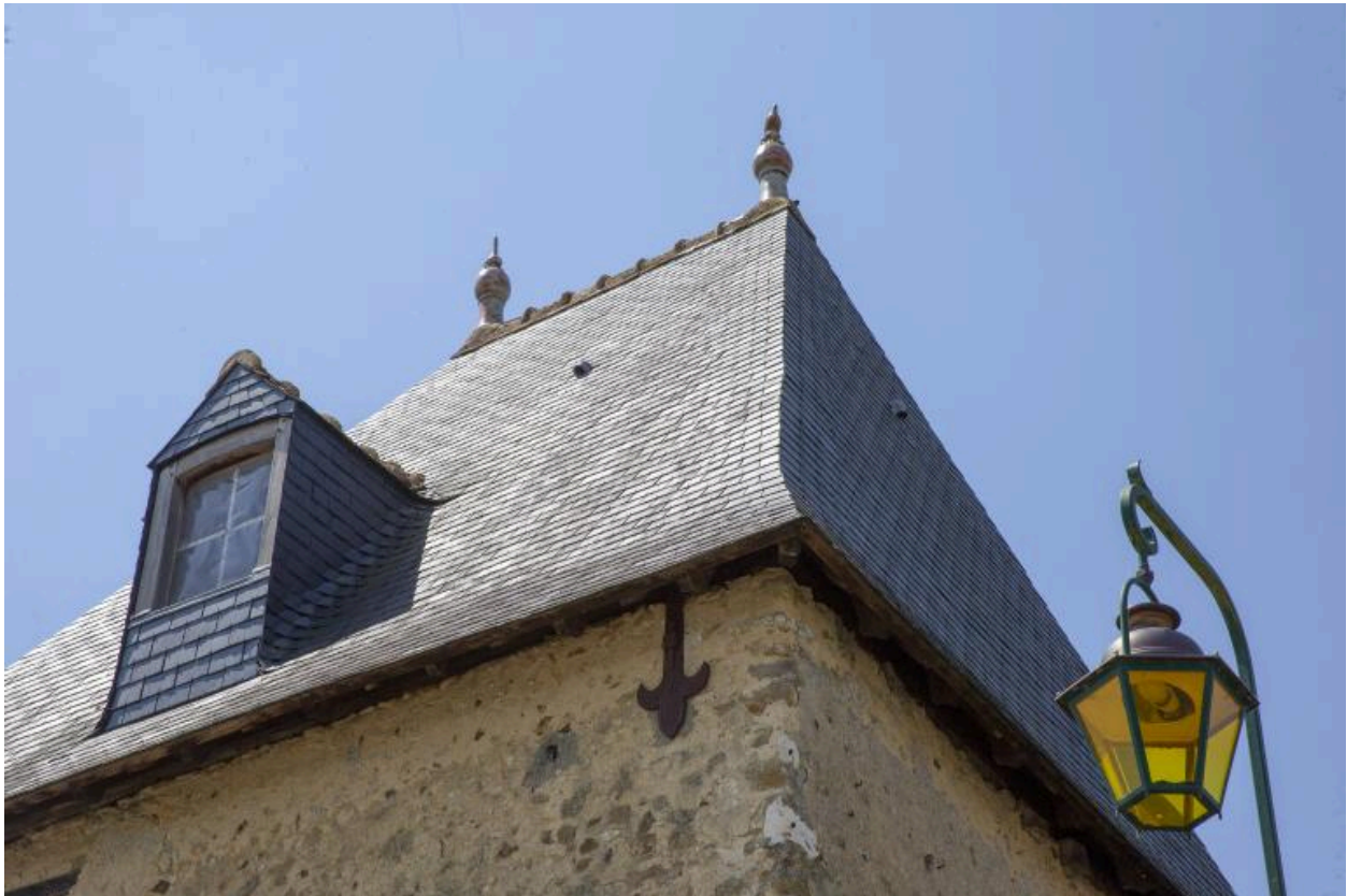
La toiture du pavillon.
