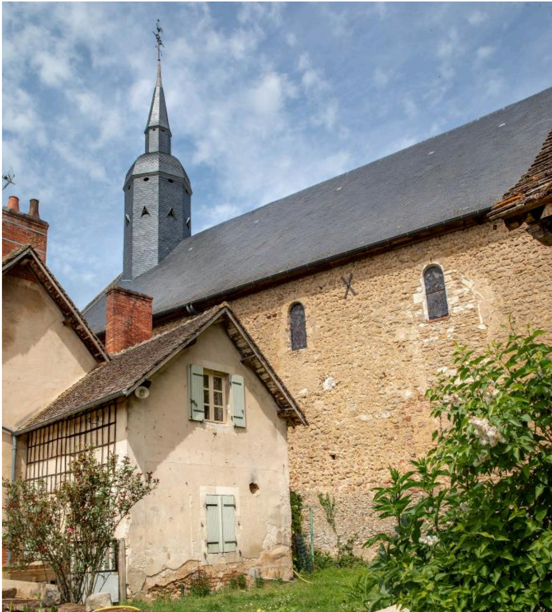
Le mur sud de la nef.
